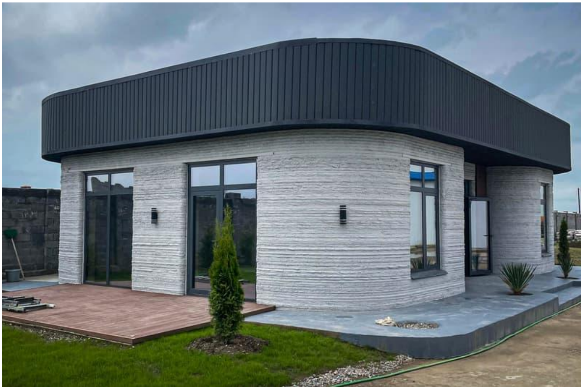
Рис. 10Б. Будинок з глиняних матеріалів побудований великим 3д-принтером
