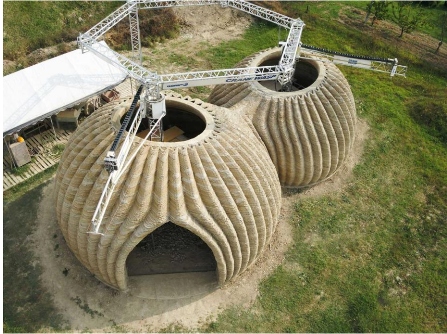
Рис.30. Процес будівництва з глиняних матеріалів побудований великим 3д-принтером компанії WASP [74]
