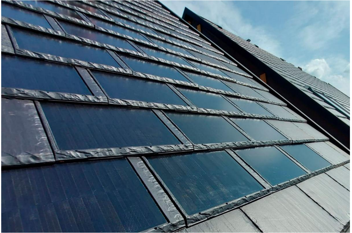
Рис.17. Керамічна черепиця з інтегрованими сонячними панелями від Tejas Borja [63]
