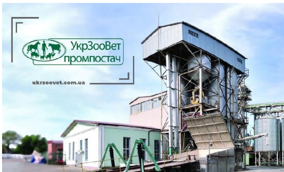
Рисунок 1.1 Зовнішній вигляд будівлі ТОВ «Укрзооветпромпостач» — офіс та виробничий цех.
