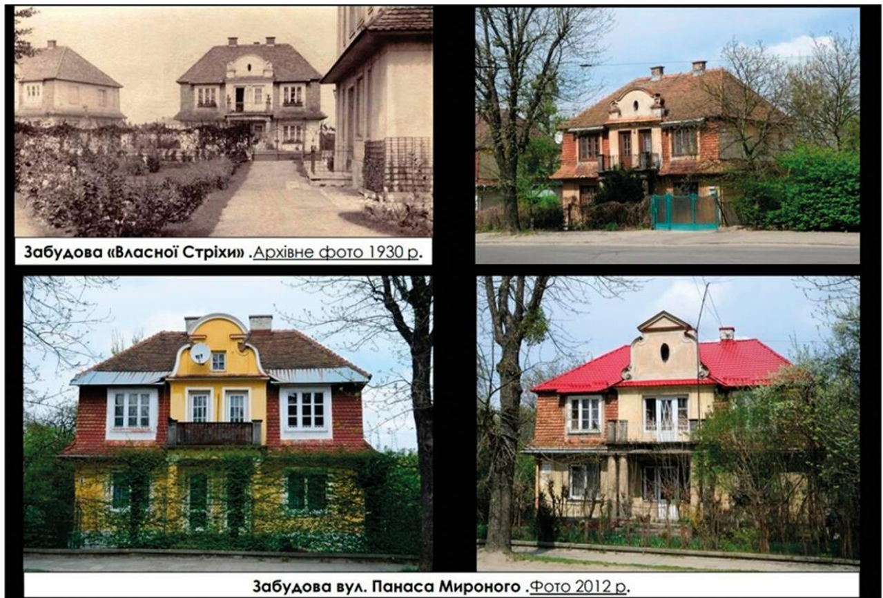
Рис. 13. Історична забудова ділянки «Софіївка». Сучасні фото.
