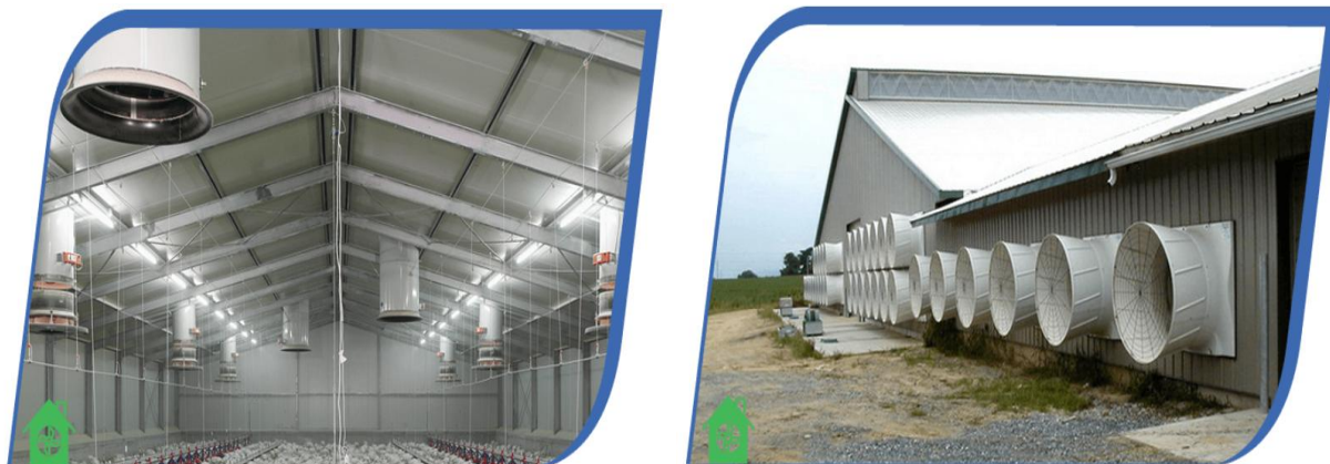
Рис. 4. Припливно-витяжна вентиляція, що встановлюється у пташниках для покращення відтоку відпрацьованого повітря і оптимального мікроклімату (фотографія взята із [15])
