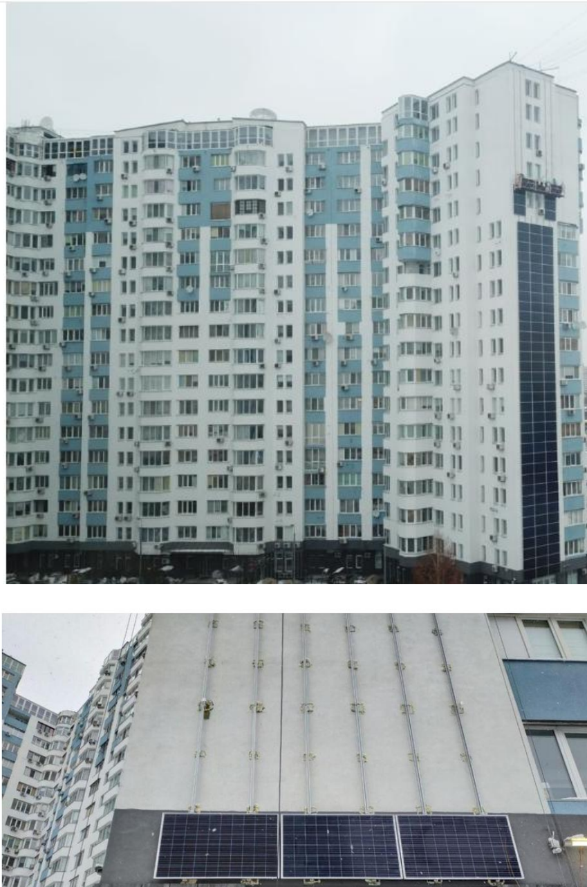
Рис. 17. Термомодернізований будинок у Києві із встановленими сонячними панелями на зовнішній стіні (фотографія із сайту https://ua-energy.org/uk/posts/rekordna-enerhomodernizatsiia-bahatopoverkhovyi-budynok-termos-iz-soniachny-my-paneli-amy-i-vitriakamy ]
