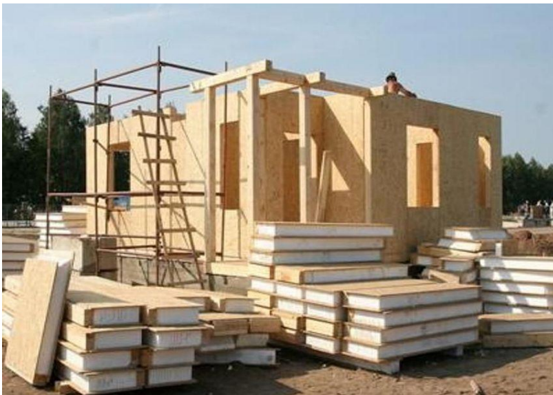
Ілюстрація 6. Будівництво будинку з сендвіч панелей.
