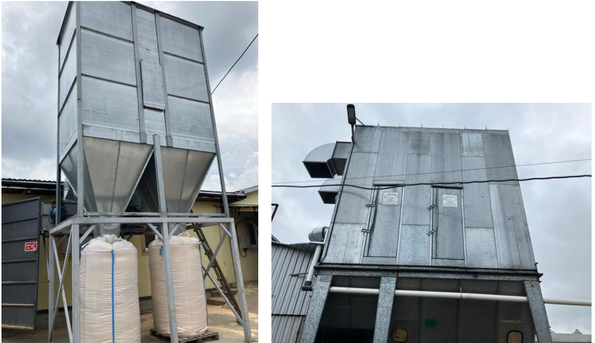
Рис. 3.2. циклони для очистки забрудненого повітря деревообробних виробництв.
