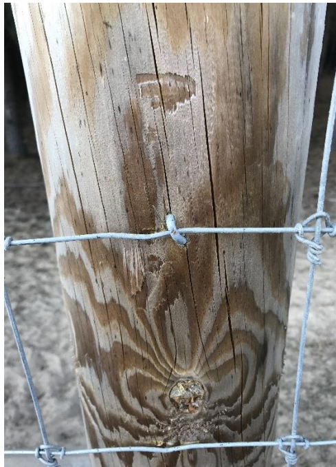
Рис. 4.3. Прикріплення сітки з фіксованим вузлом до стовпа
