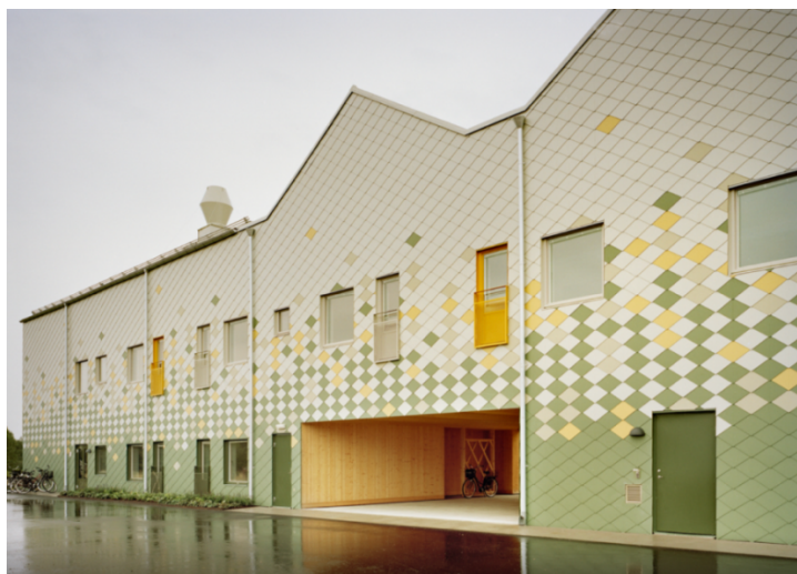
Рис. 2.20 – Фасад будівлі покрит візерунками з фіброцементу
