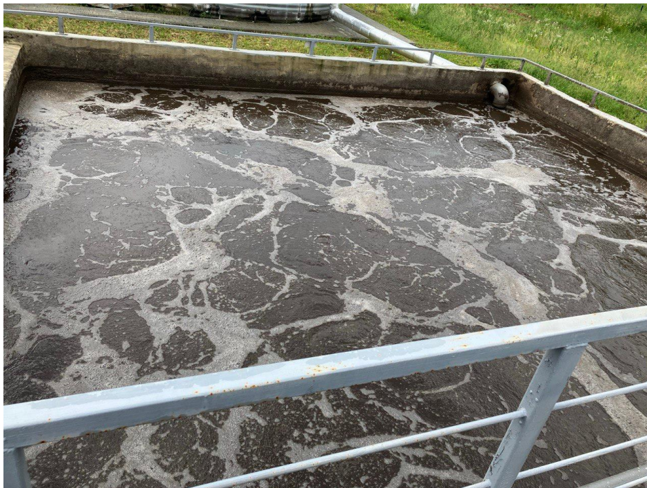
Рис. 1.3. Відстійник для очищення стічних вод.
