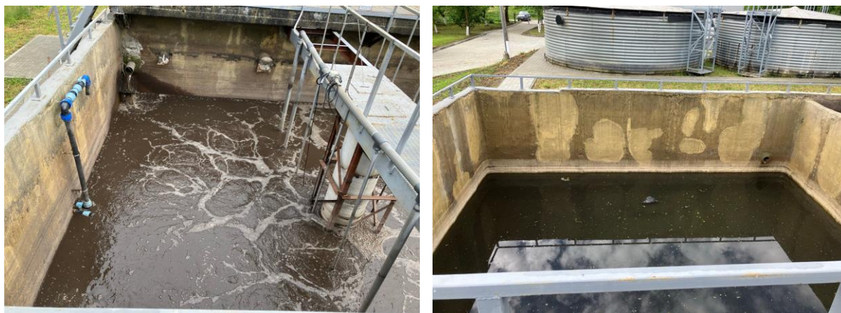
Рис. 5.1 Відстійники із стічною водою для очищення
