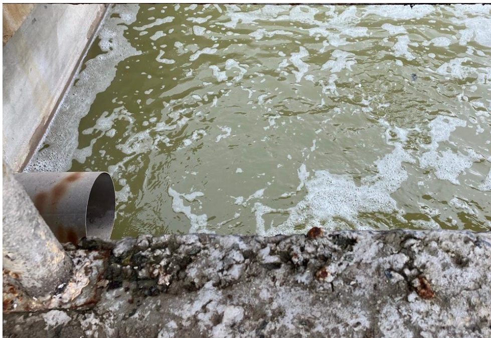
Рис. 4.2. Відстійник для доочистки стічної води після очистки від залишків целюлози.
