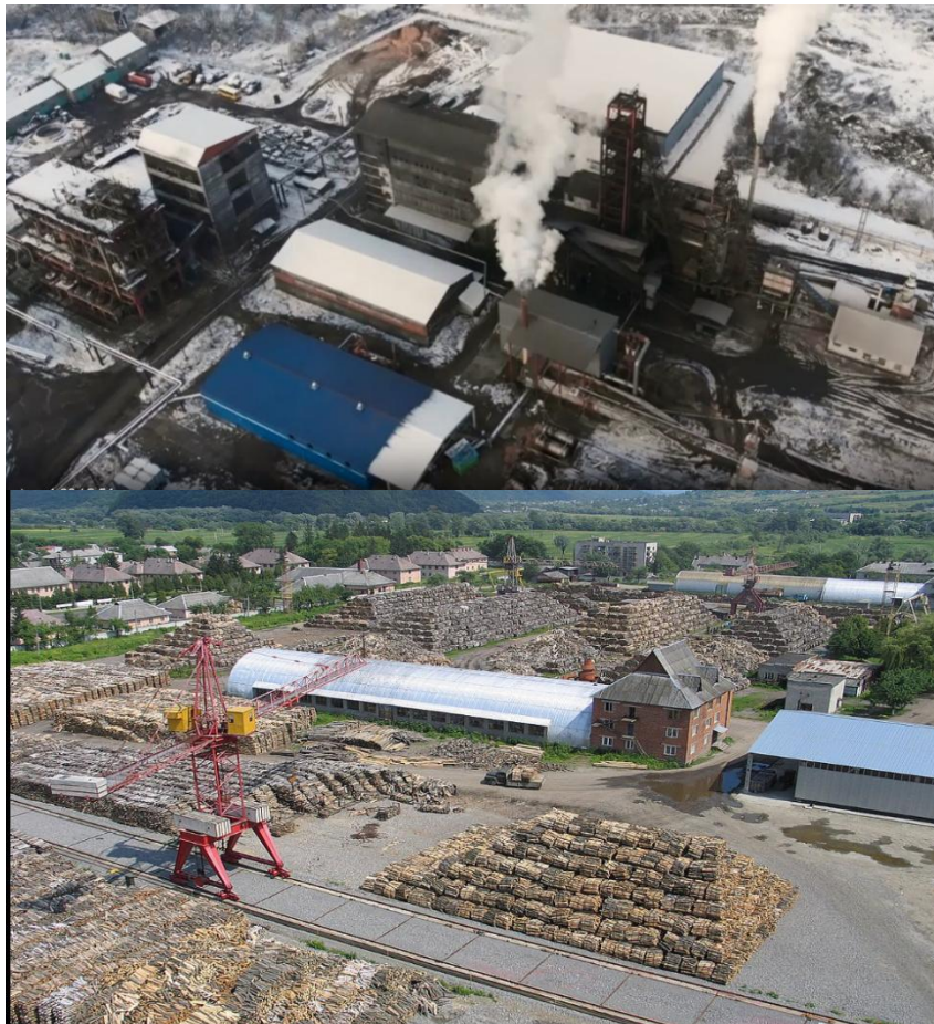
Рис. 16. Загальний вигляд Перечинського лісохімічного комбінату (вигляд згори) та складів із сировиною
