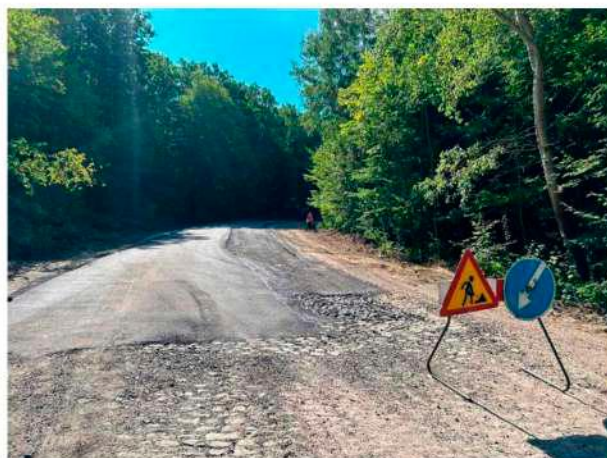
Рисунок 3.9 – Облаштування на початковому етапі ділянки реконструкції автошляху дорожніми знаками
