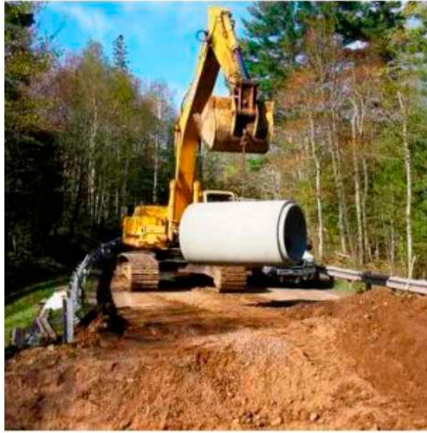
Рисунок 3.2 – Здійснення монтажних-будівельних робіт при улаштуванні секційних елементів дорожніх водопропускних залізобетонних труб
