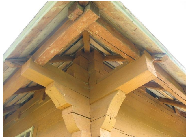
Рисунок 1.13 Колишня плебанія: загальний вигляд і фрагмент конструкції піддашся.
