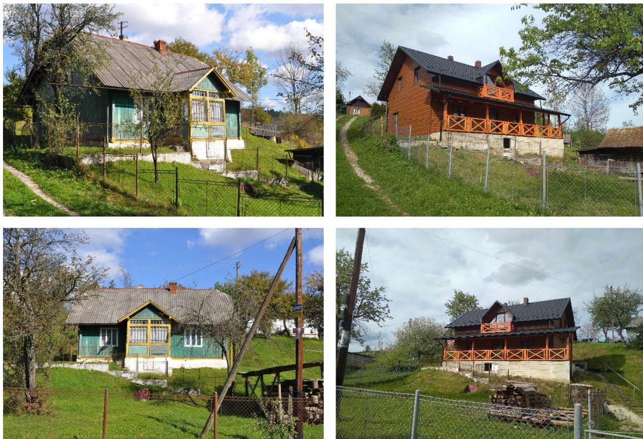
Рисунок 1.15. Вигляд житлового будинку з компактним планом: а) світлина 2017 р. до перебудови; б) світлина 2021 р. після перебудови.
