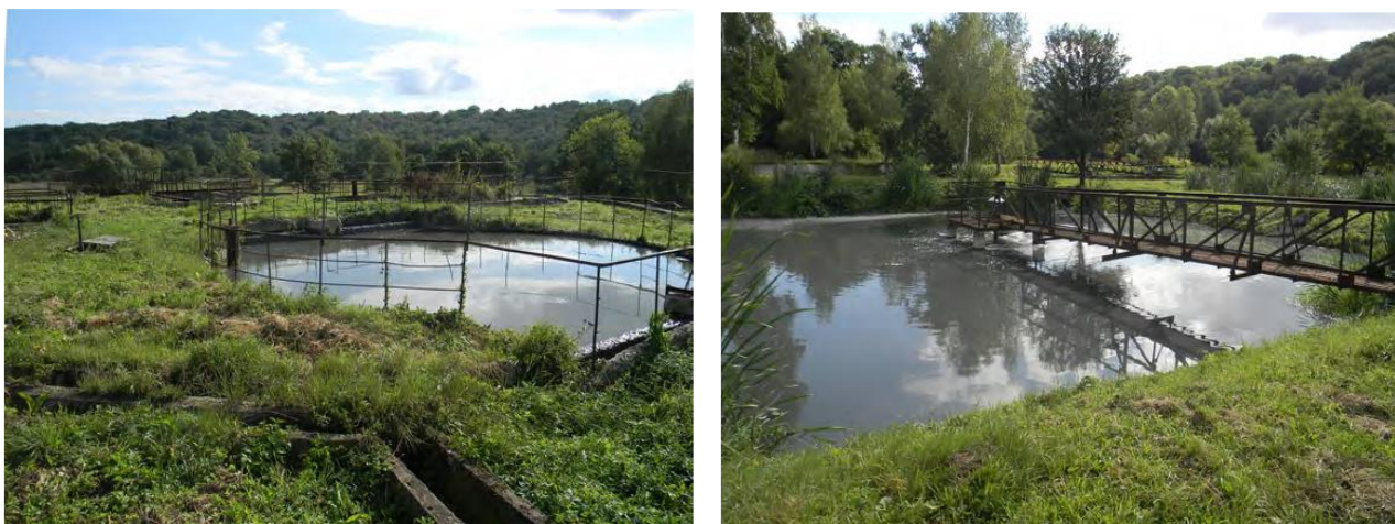
Рис. 4.1. Фото місць скиду стоків, очисні споруди [15]
