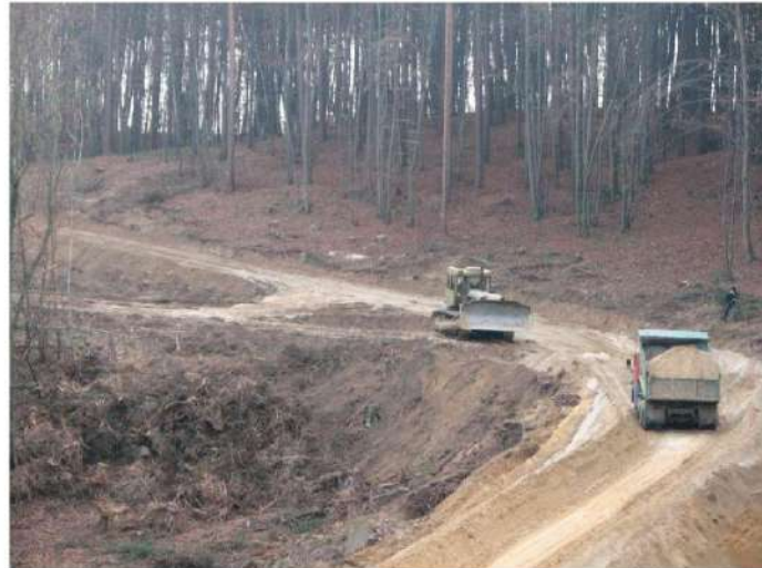
Рисунок 1.5 – Формування земляного полотна на повороті лісової дороги в горбистих лісоексплуатаційних умовах
