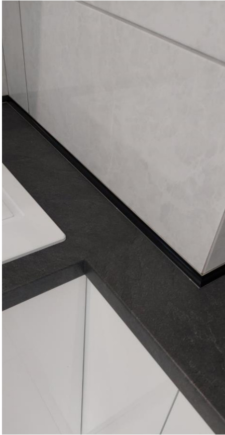
Рис 2.8 З'єднання стільниці клеєм Kleiberit PUR 501
