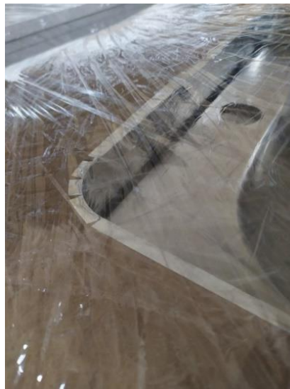
Рис. 2.4 Зона під мийкою оброблена алюмінієвим скочем
