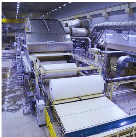
Рис. 5.2. Лінія виготовлення паперу із належною приточно-витяжною системою.
