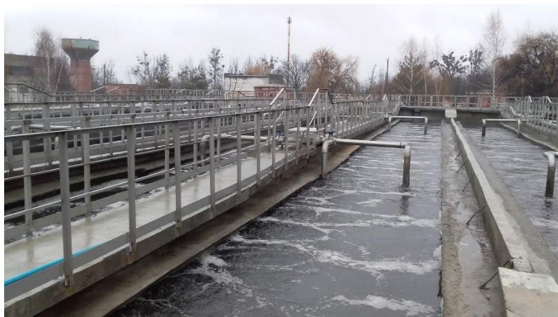
Рис. 4.4. Очищення стічних вод за допомогою відстійників.
