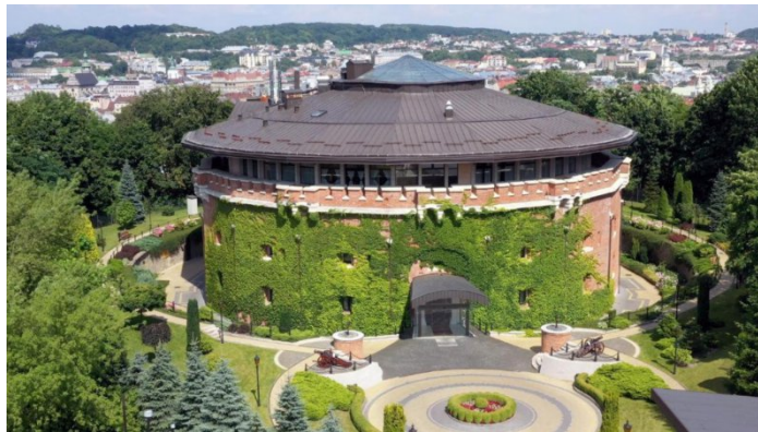
Рис. 1.4. Облаштований Готель-ресторан "Citadel Inn"[21]
