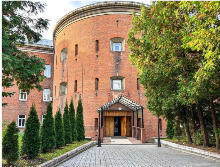
Рис. 1.5. Триповерховий корпус казарм [2]
