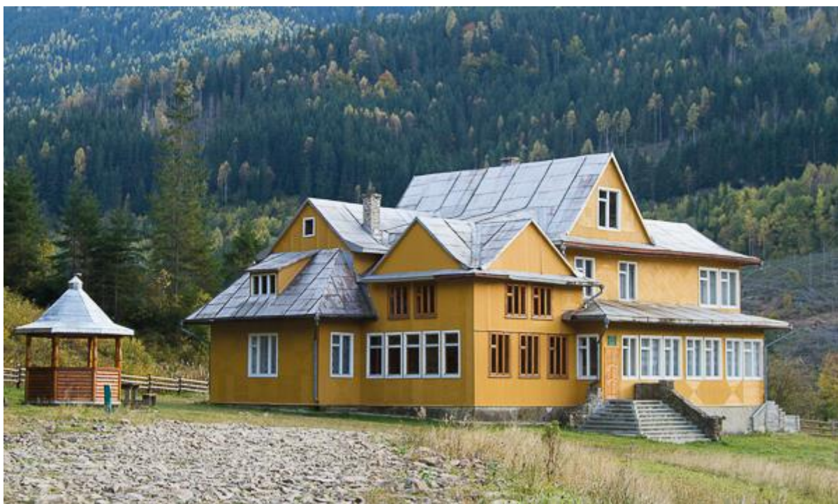
Рис.1.1. Приміщення Дарівського лісництва
