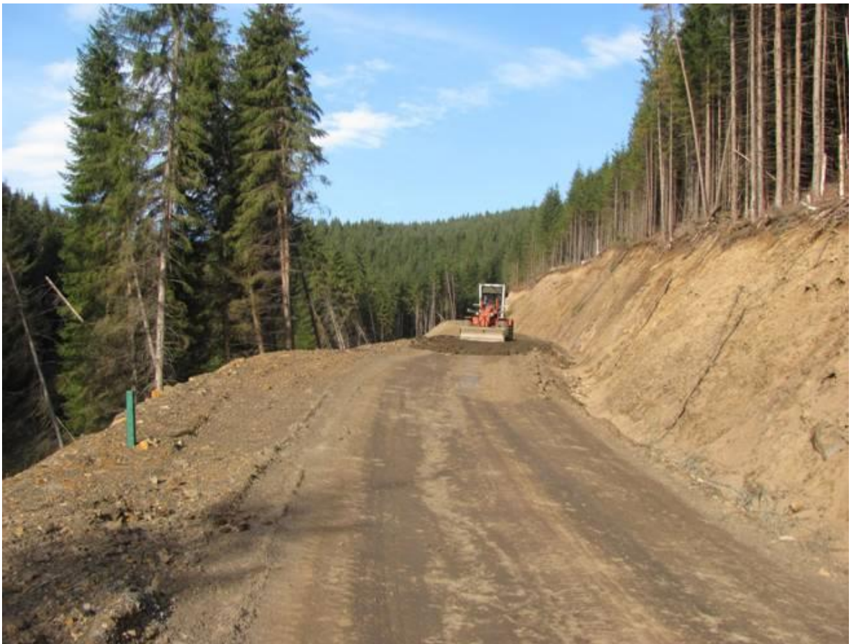
Рис. 3.2. Будівництво нових лісових доріг
