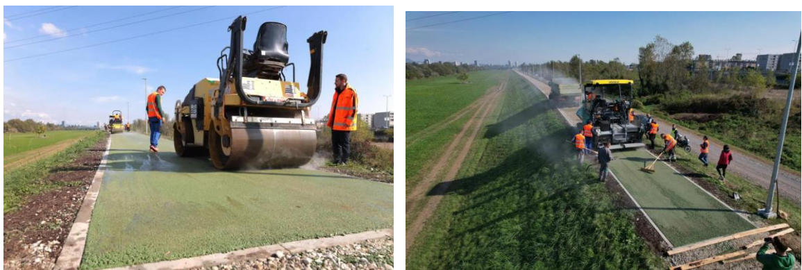
Рис.12. Застосування екоасфальту для прокладення велодоріжки у Загребі, Хорватія.
