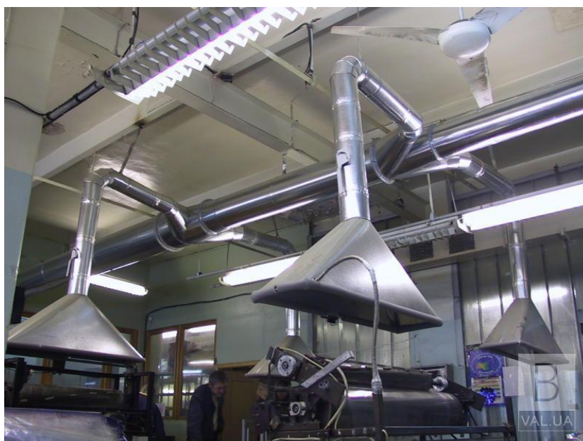
Рис. 5.2. Витяжна установка у зоні склеювання.
