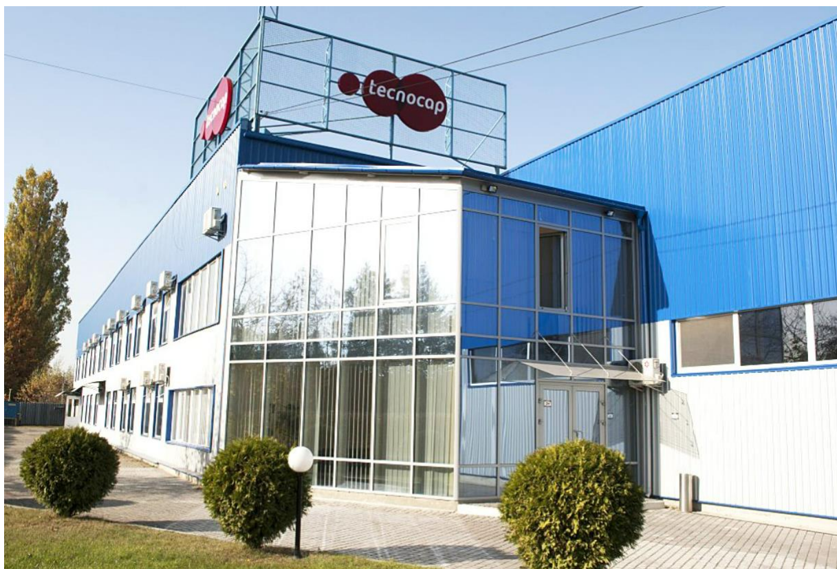
Рис. 2.2. Завод з виробництва готових металевих виробів ТзОВ «Технокап УА» у Жовківській територіальній громаді Львівської області
