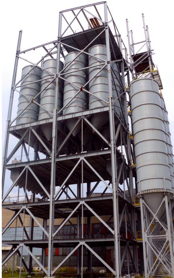
Рисунок 1.3 – Загальний вигляд змонтованої конструкції циклонів.
