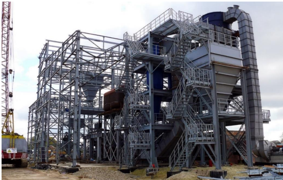
Рисунок 1.2 – Загальний вигляд змонтованої конструкції бункерів.
