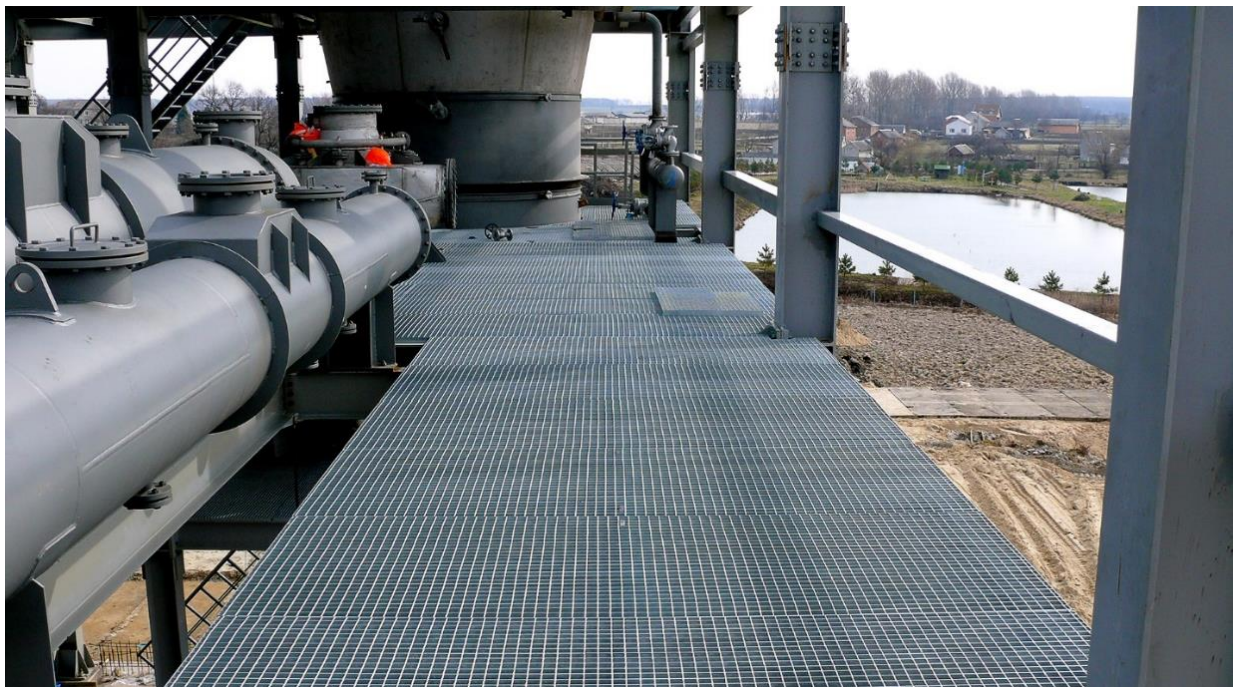
Рисунок 1.5– Загальний вигляд конструкції гратчастого настилу.
