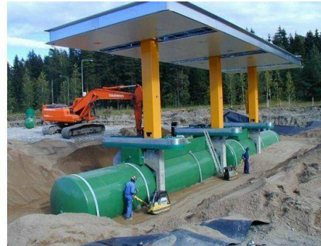
Рис. 3.2. Встановлення підземних резервуарів для нафтопродуктів.
