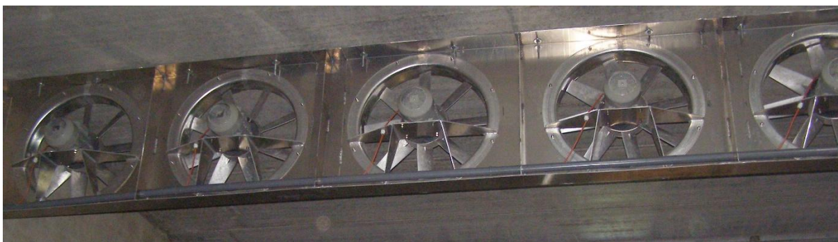
Рисунок 1.9. Фото рами з осьовими реверсивними вентиляторами конвективної сушарки в будівельних огородженнях.
