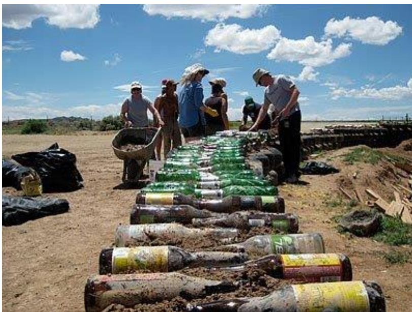
Рис. 3.3. Початок будівництва з скляних пляшок.
