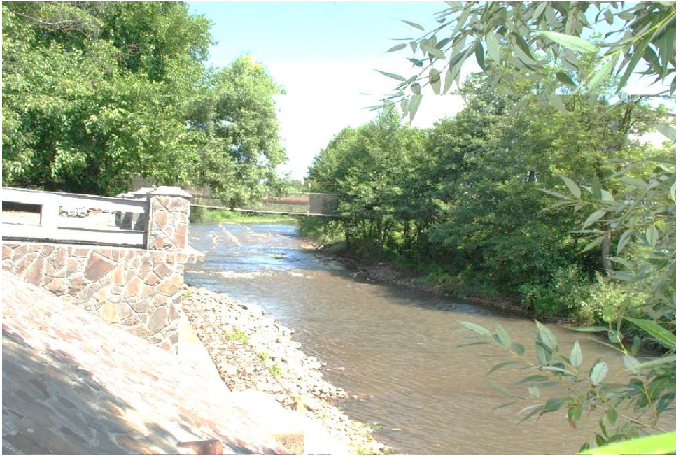
Рис. 3.4. Берегоукріплювальні роботи на річці Іршава біля міста Іршава
