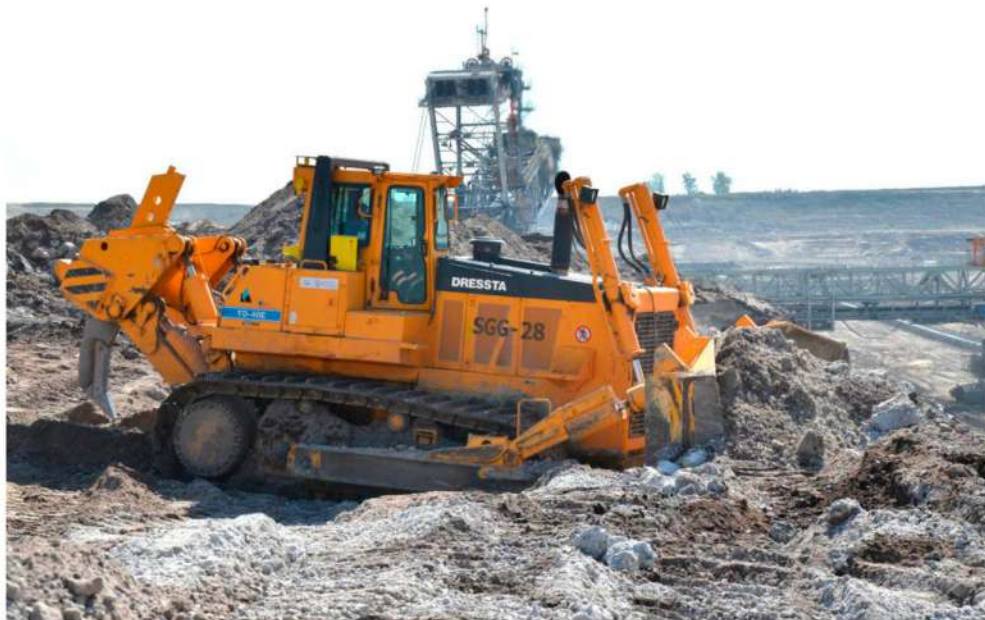
Рисунок 1.2 – Виконання технологічних операцій з переміщення ґрунту базовою машиною Dressta TD-40 XP [1]
