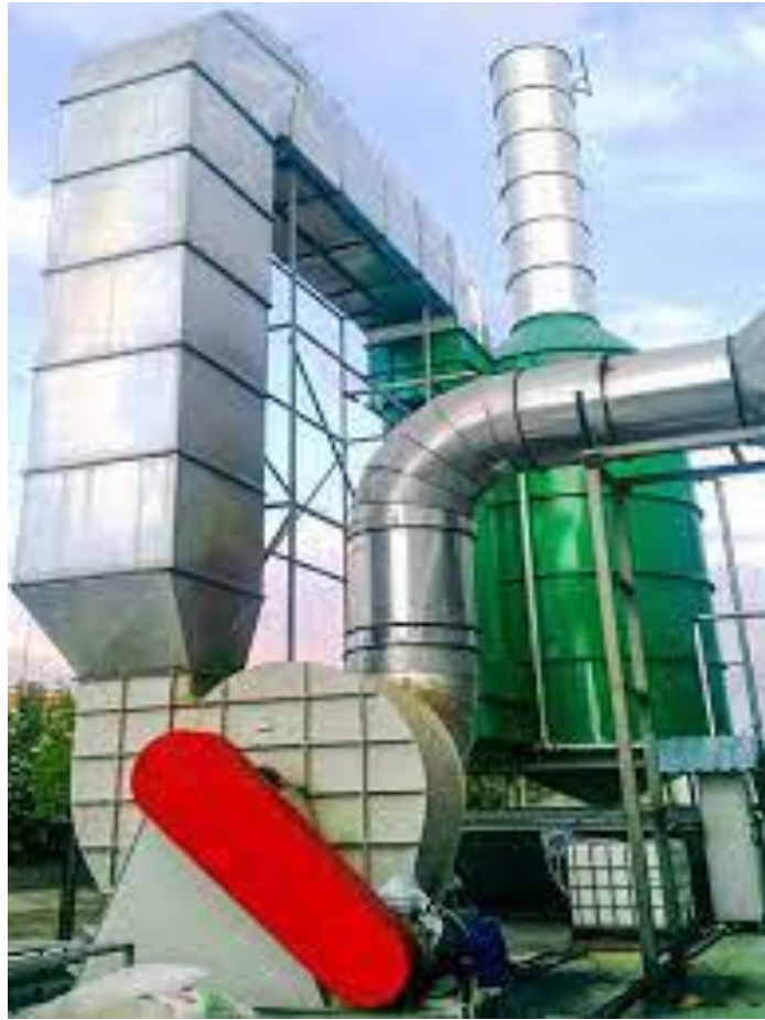
Рис. 4.3 Загально цехову вентиляційну систем.
