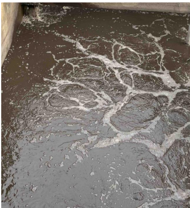
Рис. 3.2. Вода після механічного очищення від залишків целюлози.
