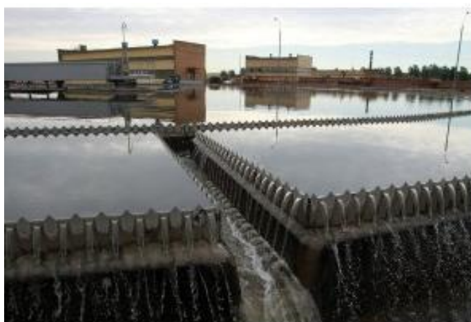
Рис. 3.5. Первинний відстійник
