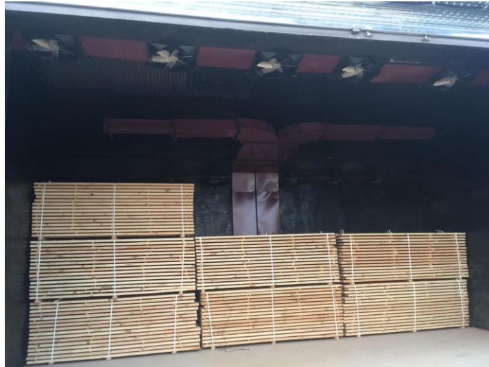
Рис. 5.2. Сушильна камера із штабелями ламелей.
