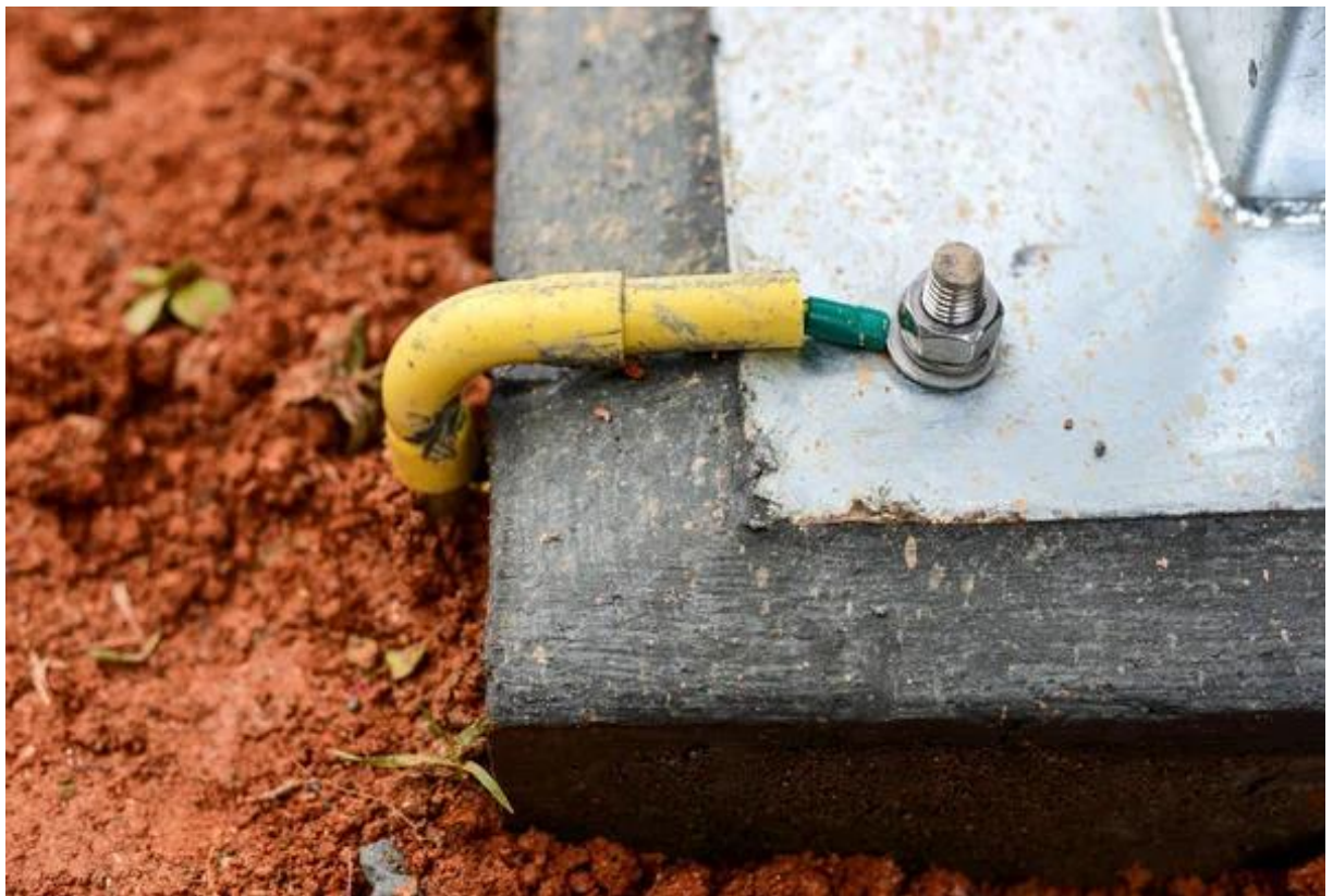
Рис. 5.4. Заземлення технологічного обладнання.
