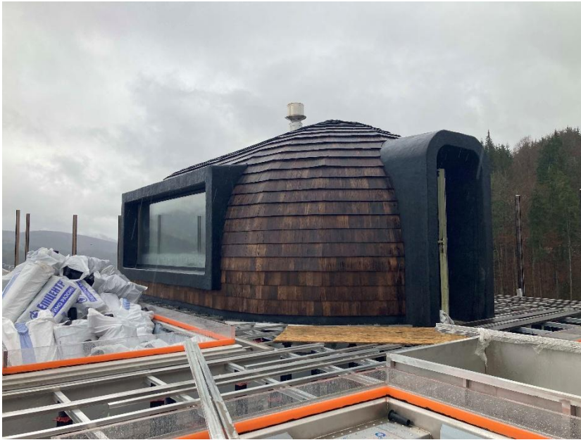
Рисунок 2.1. Обливання будівлі фінської бані термічно модифікованим ясенем на будівлі відпочинкового комплексу.
