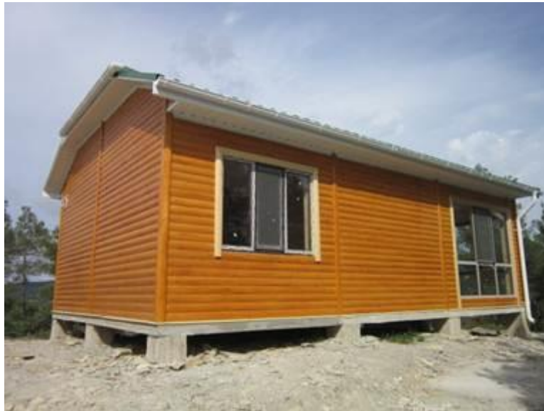
Рис. 24. Типовий одноповерховий каркасно-щитовий будинок, Канада.
