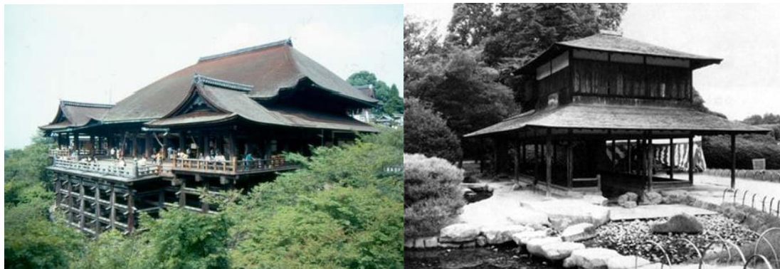
Рис. 31. Тип напівжорсткого каркасу без діагональних елементів.
