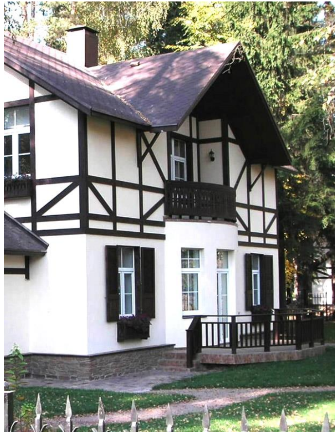
Рис. 17. Приклад будівлі з фахверкових конструкцій.
