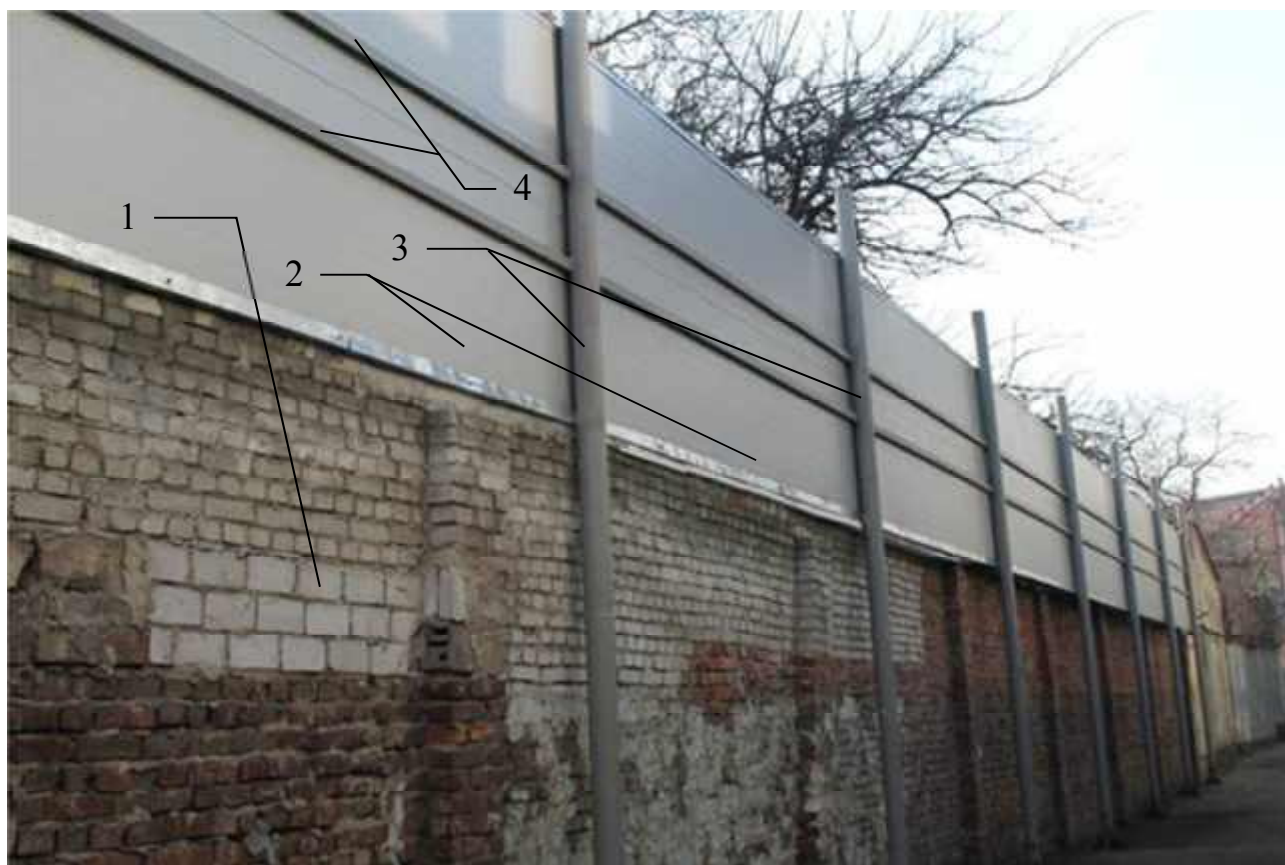
Рис. 4.4. Загальний вигляд шумозахисного екрана:
