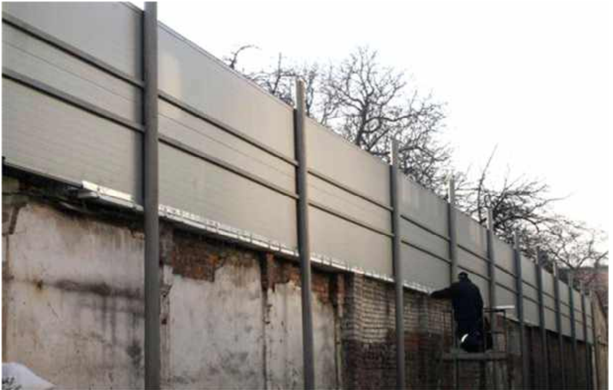
Рис. 4.5. Монтаж акустичного екрана та герметизація зони прилягання до цегляної стіни.
