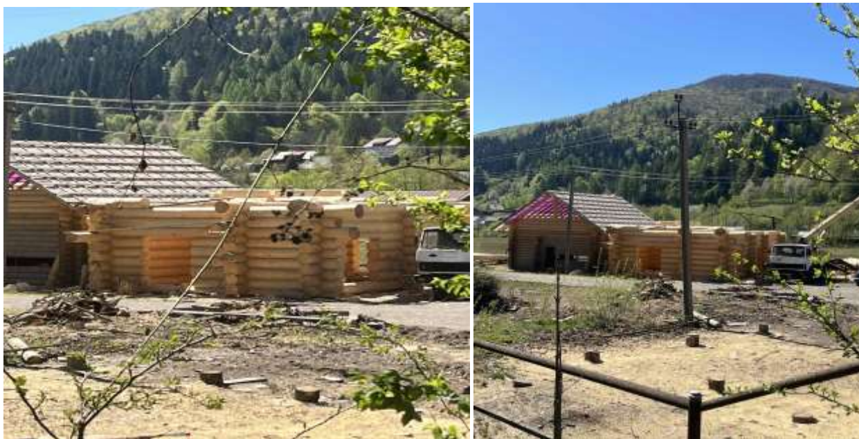
Рис. 2.2. Вигляд будинку, що будується на підприємстві
