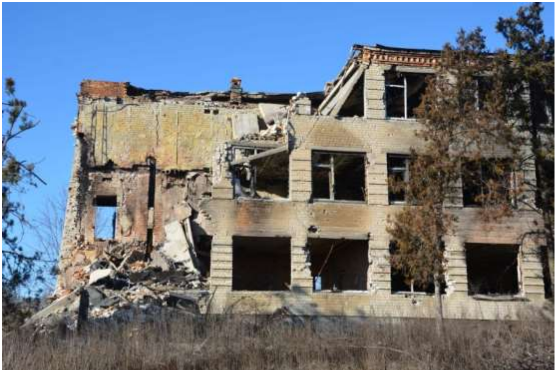
Рис. 3.3. Зруйнована школа у с. Вільхівка
